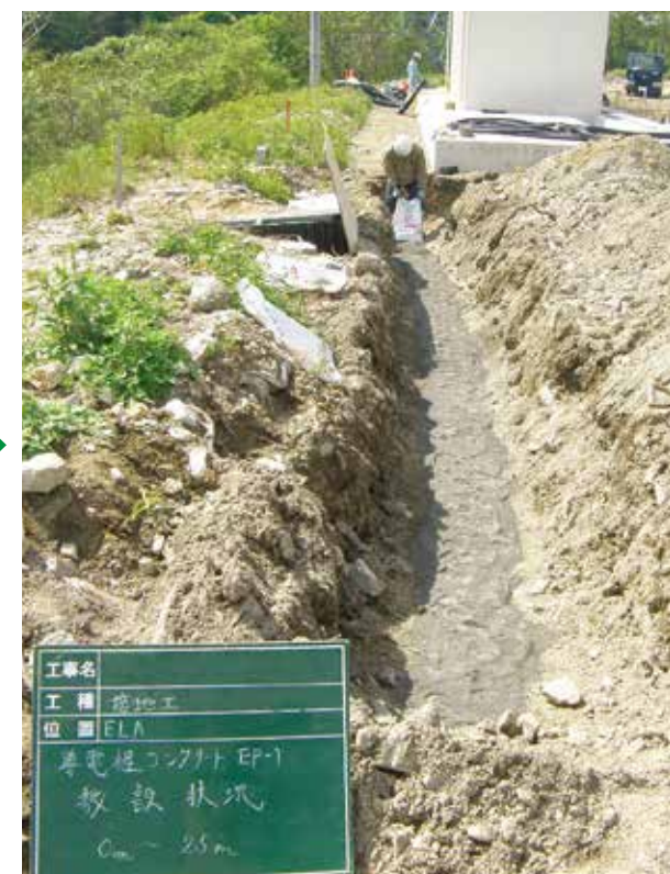
【ホクデンEP-1の敷設状況】
