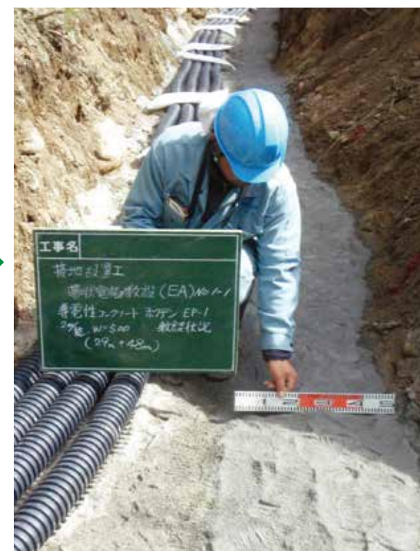
【ホクデンEP-1の敷設状況】
