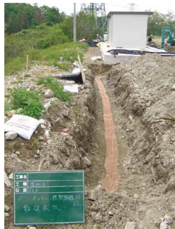
【パワーメッシュと裸軟銅線の敷設状況】
