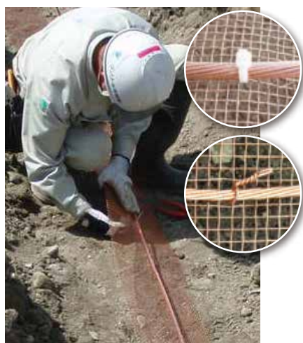
帯状電極 パワーメッシュと裸銅線敷設
