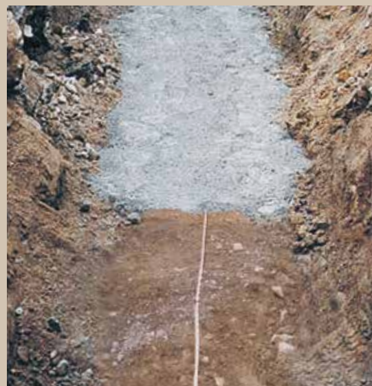
【裸銅線】EP-1 敷設
