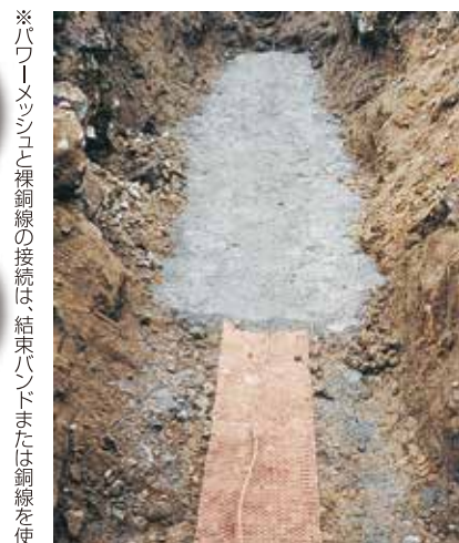
【パワーメッシュ併用】EP-1 敷設
