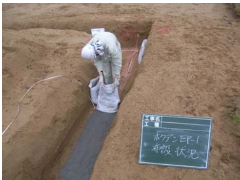
ホクデンEP-1敷設
