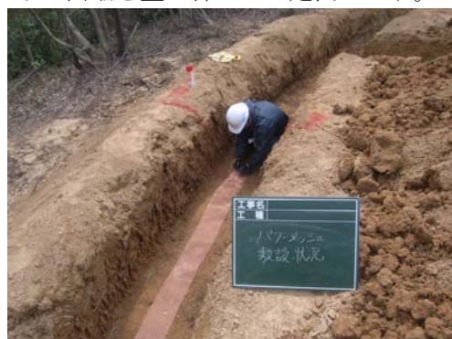
パワーメッシュ敷設
