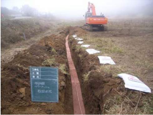
裸銅線の敷設
