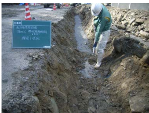
人力による埋め戻し
