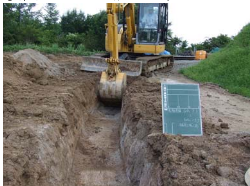
写真1. 重機による掘削
